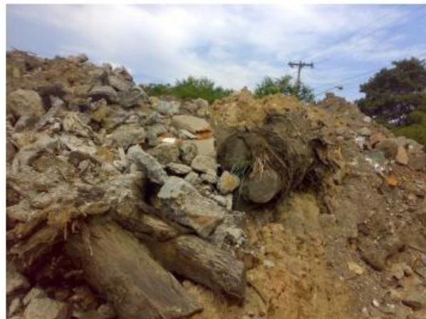
**FIGURA 07** – Entulho de obra contaminado com diversos materiais
