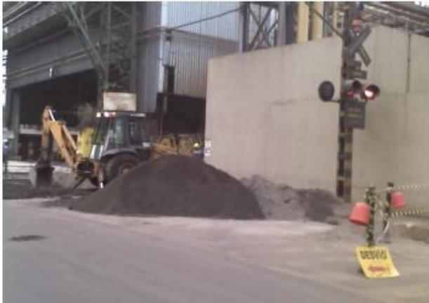
**FIGURA 24** – Material para sub base de soca de linha
